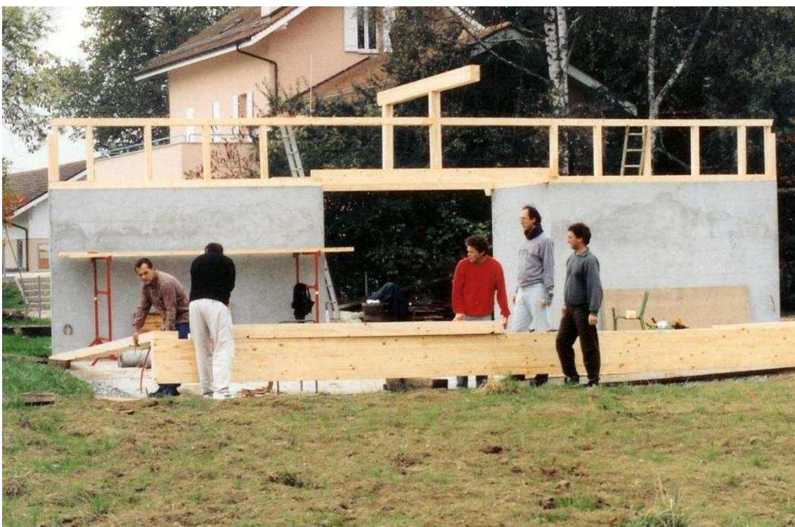
Septembre 1995, début de la pose de la charpente sur les murs
