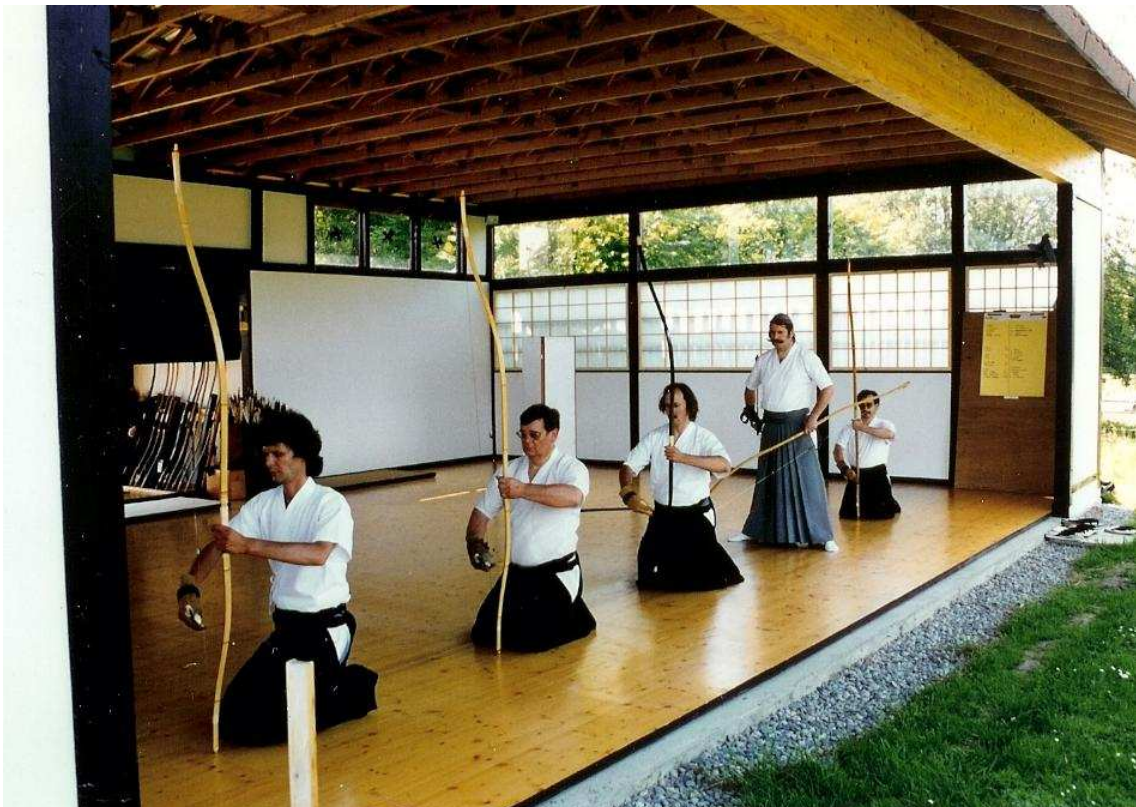
1997 - Séminaire AHK dans un dojo presque terminé il ne manque que les portes coulissantes, et un peu d'équipement intérieur Les portes furent posées un an plus tard et l'équipement intérieur en 2001
