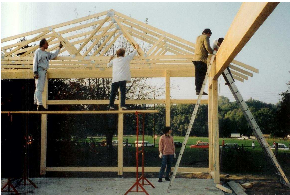
1995 – Après la pose de la poutre, la pose des éléments de charpente
