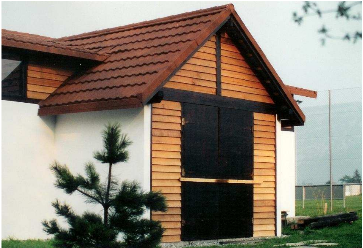
Printemps 1996 – Le bâtiment est terminé, prêt pour l'inauguration
