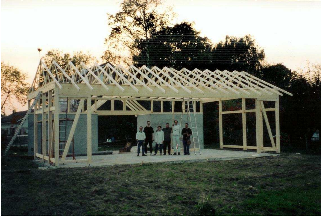
Automne 1995 – Fin du long weekend du Kyudo Kai ... la charpente est posée
