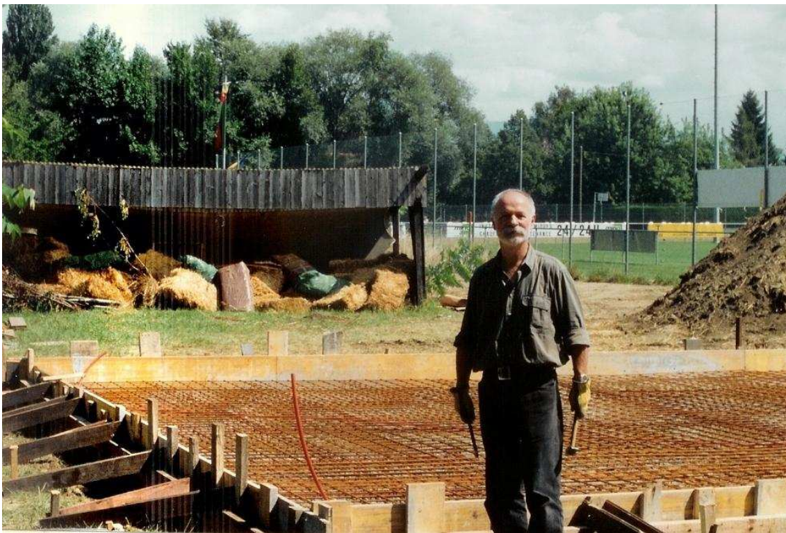
Aout 1995, Jean devant les travaux de la dalle
