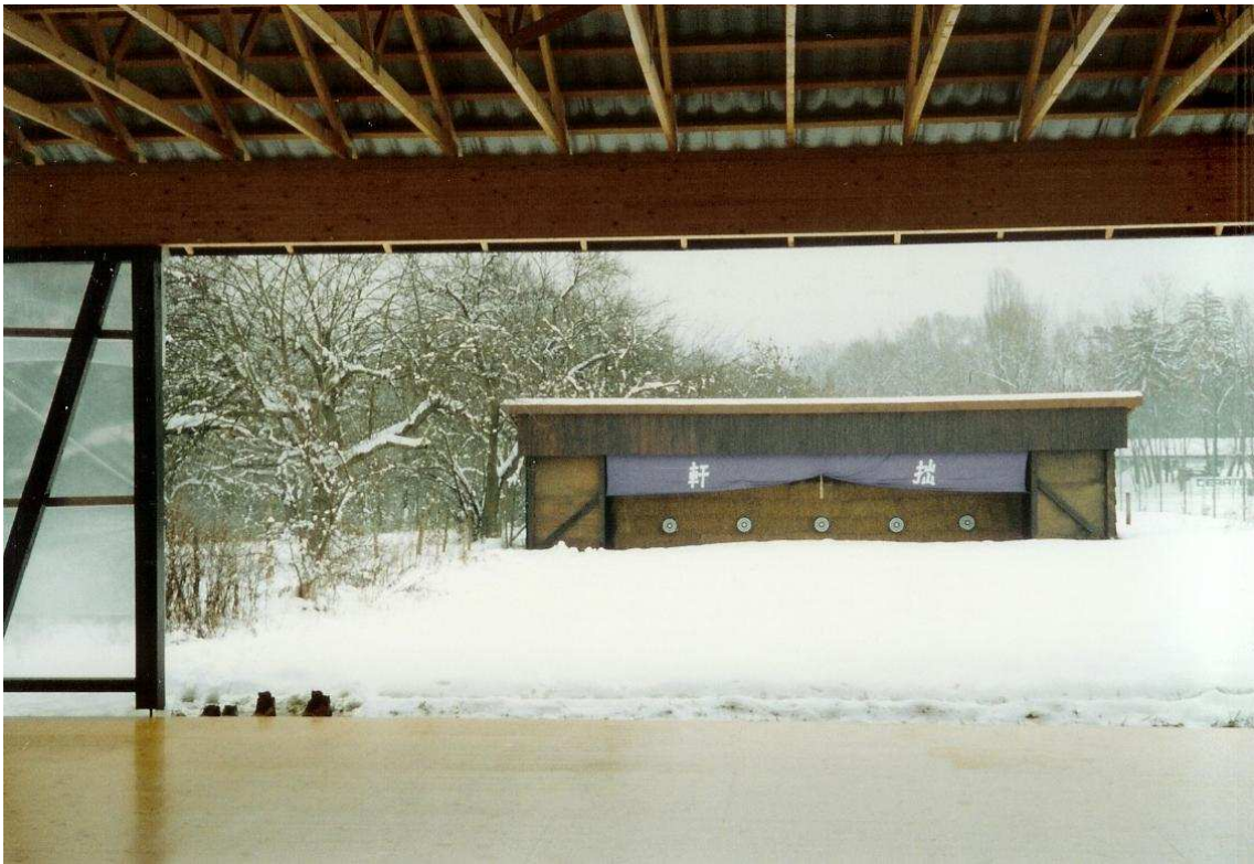
1997 - Le dojo, sous toit, mais avec des murs « bâchés »
