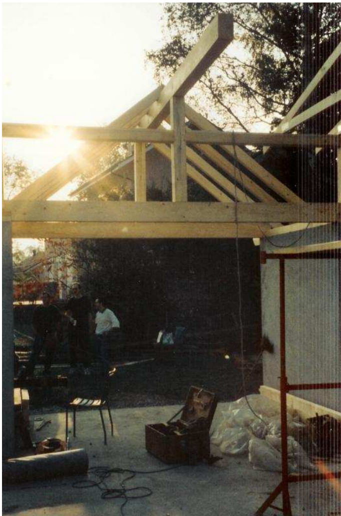
Automne 1995 – Travaux de charpente. Guillaume soutient une poutre de 12m et près de 300kg
